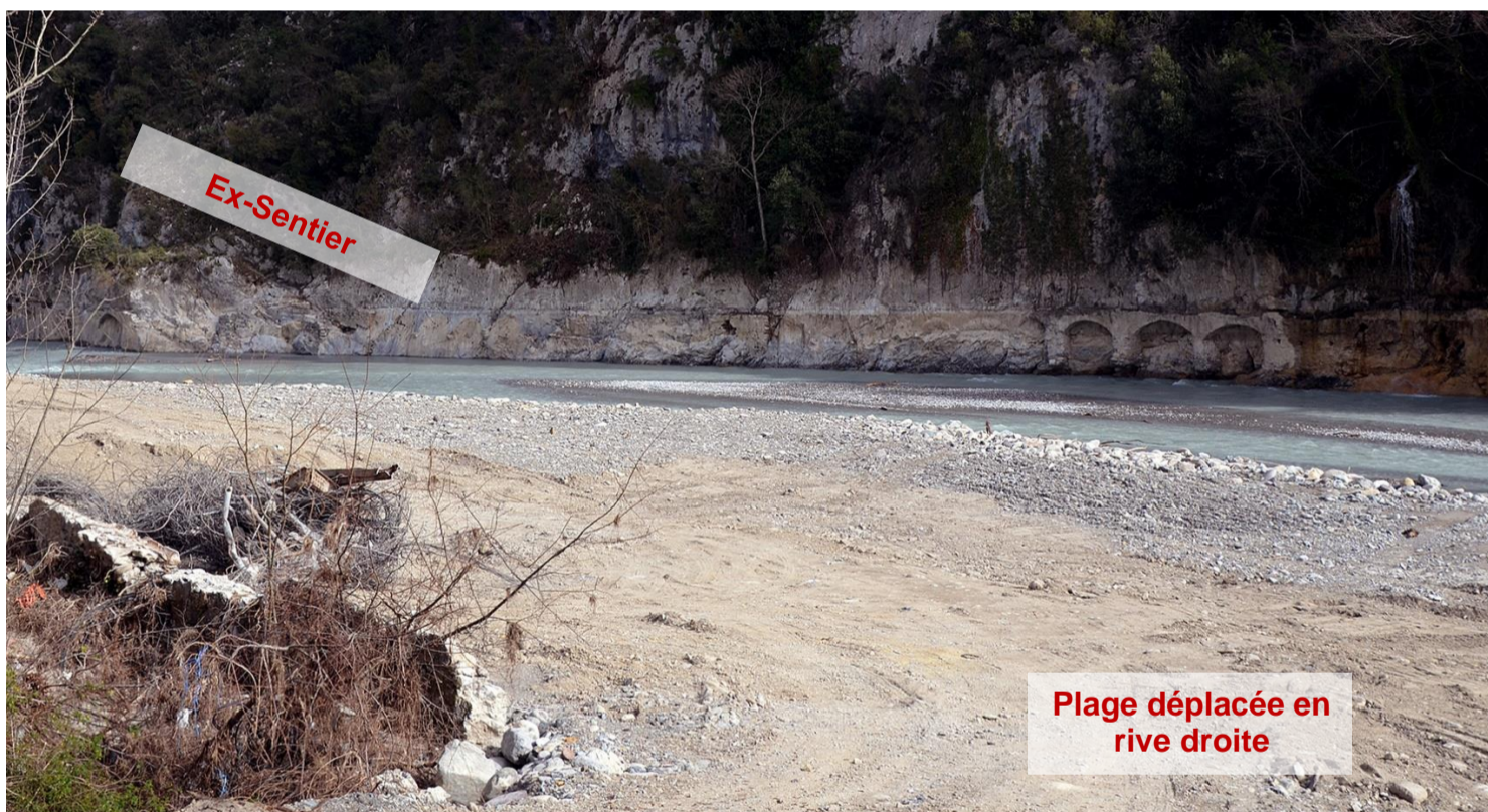
.Vue d'un trouçon sous la falaise de l'Orneglia du canal de l'Aïgara, au sud de la courbe Giandola-Canon, après la catastrophe.
