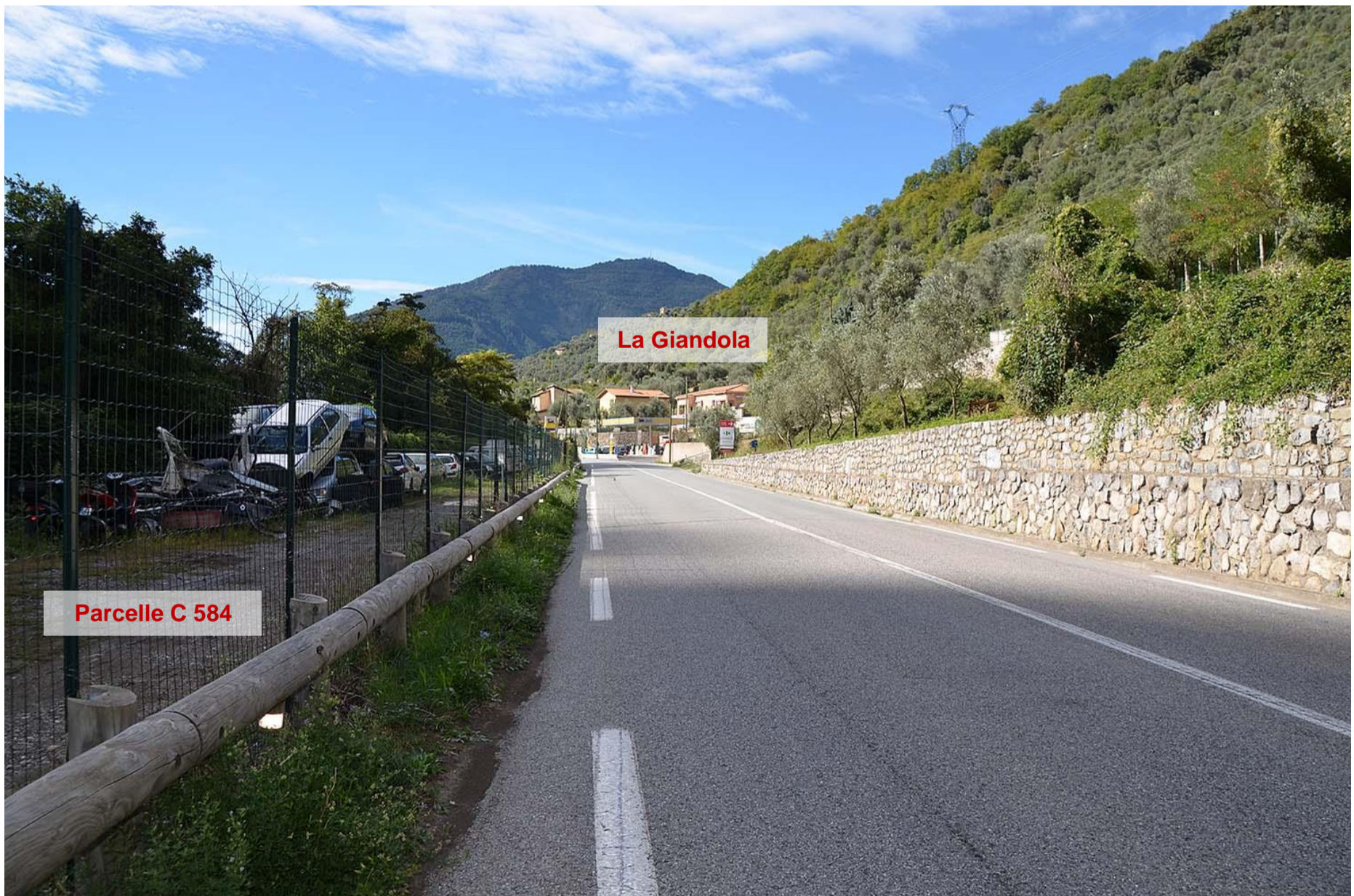
Vue Nord-Sud de la RD 6204 et de la parcelle C584 au sud de la Tana depuis la RD 6204, au sud du Pont de Veil. Octobre 2020.
