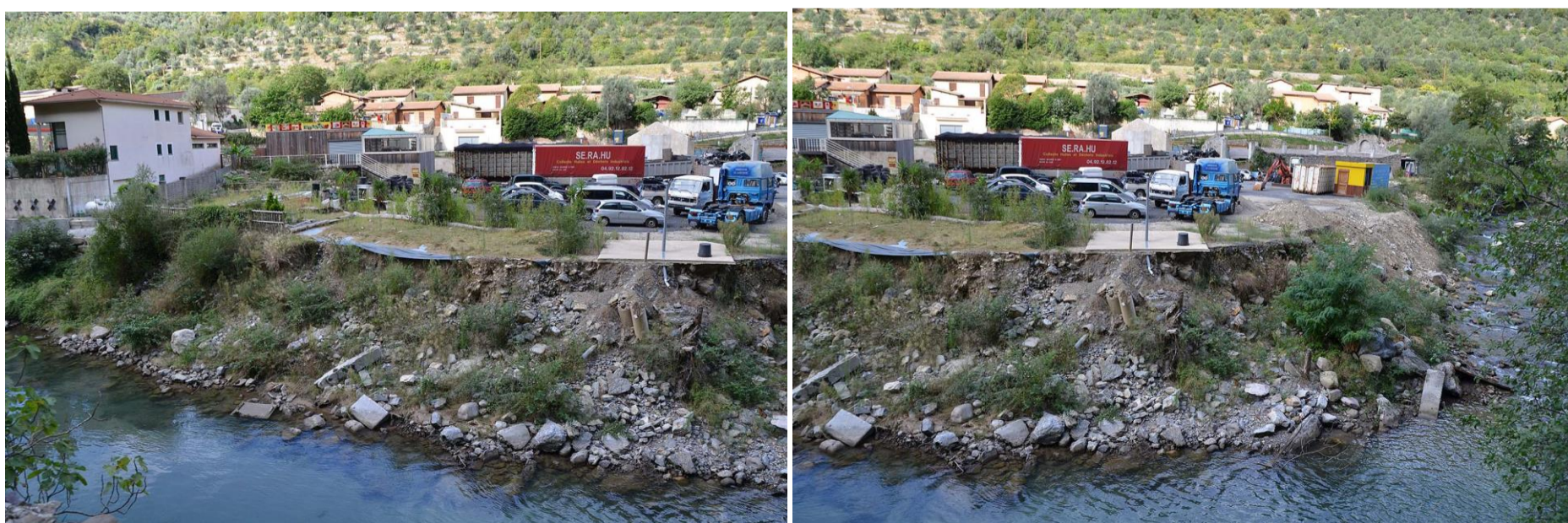
Deux vues de la parcelle C 463 remblayée avant 1995, depuis la rive gauche, en janvier 2018.
