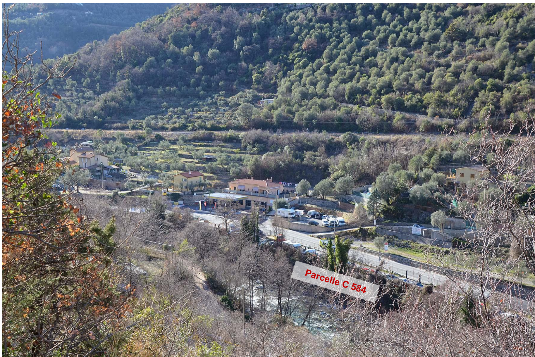
Vue depuis la rive droite, du tronçon de la RD 6204, et de la parcelle C584 en bord de rivière, alors à usage de fourrière automobile, en aval du Pont de Veil en janvier 2018.
