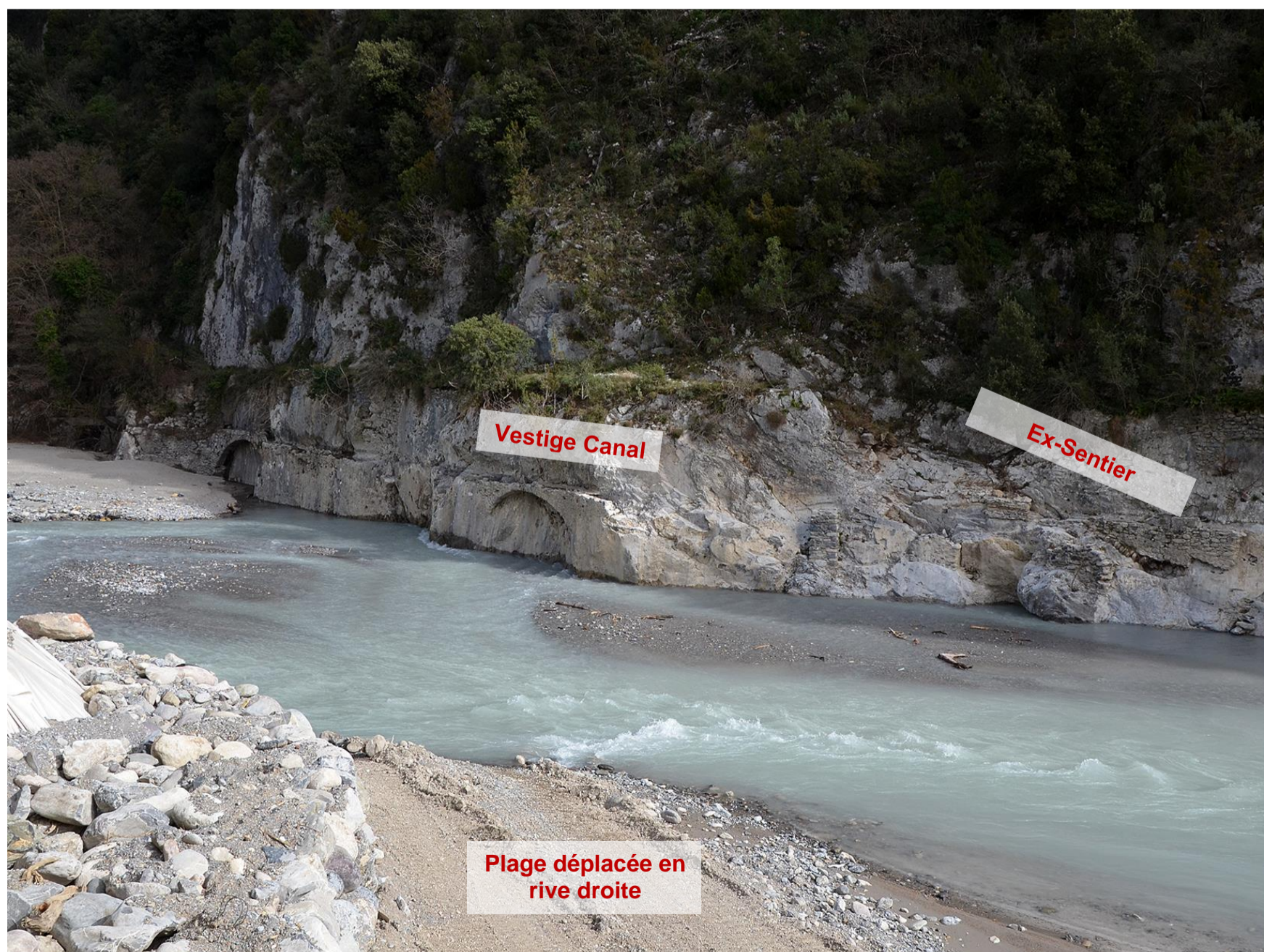
.Vue d'un tronçon en encorbellement du canal de l'Aigara, à l'extérieur de la courbe Giandola-Canon, après la catastrophe.
