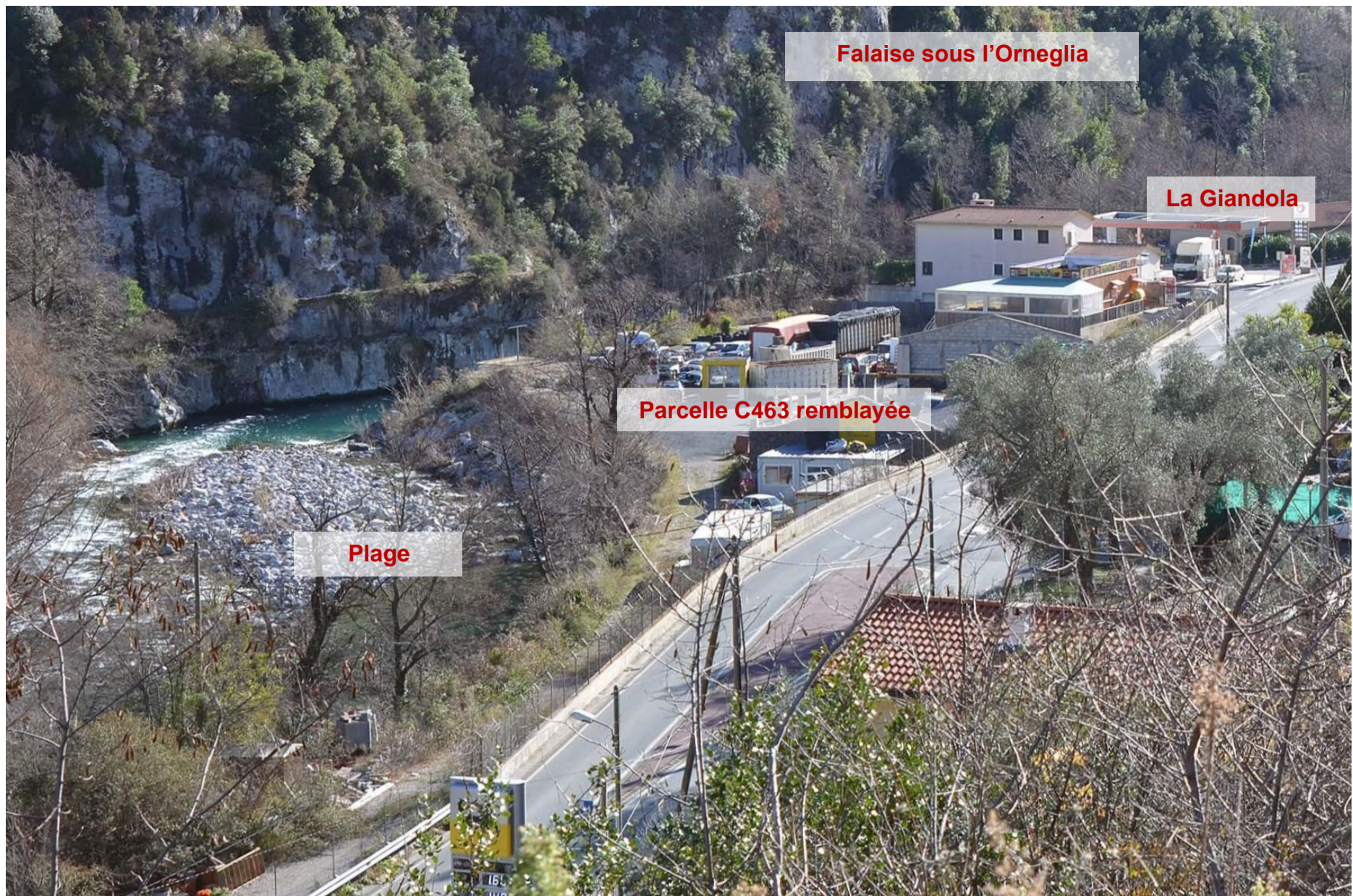
RD 6204 et parcelle C463, au niveau de La Giandola, vues en direction du sud avant la catastrophe du 2 octobre 2020.
