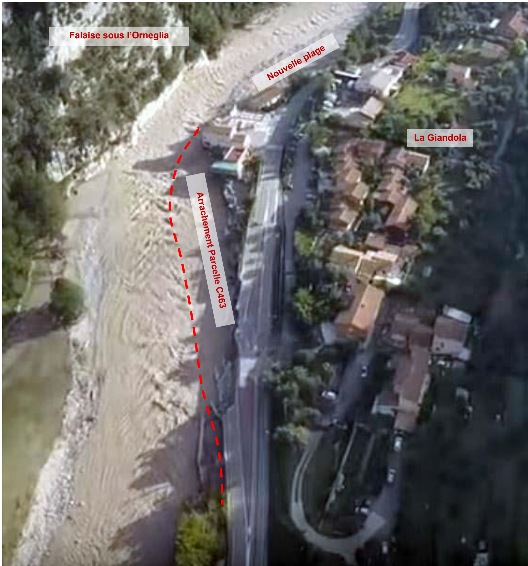
Arrachement de la RD 6204 au niveau de La Giandola, vue aérienne en direction du sud. Octobre 2020. (Source non identifiée)
