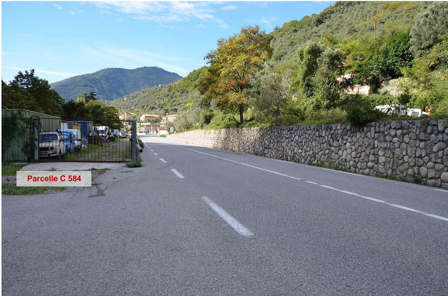
Vue Nord-Sud de la RD 6204 et de la parcelle C584 au sud de la Tana depuis la RD 6204, niveau du Pont de Veil. Octobre 2020.
