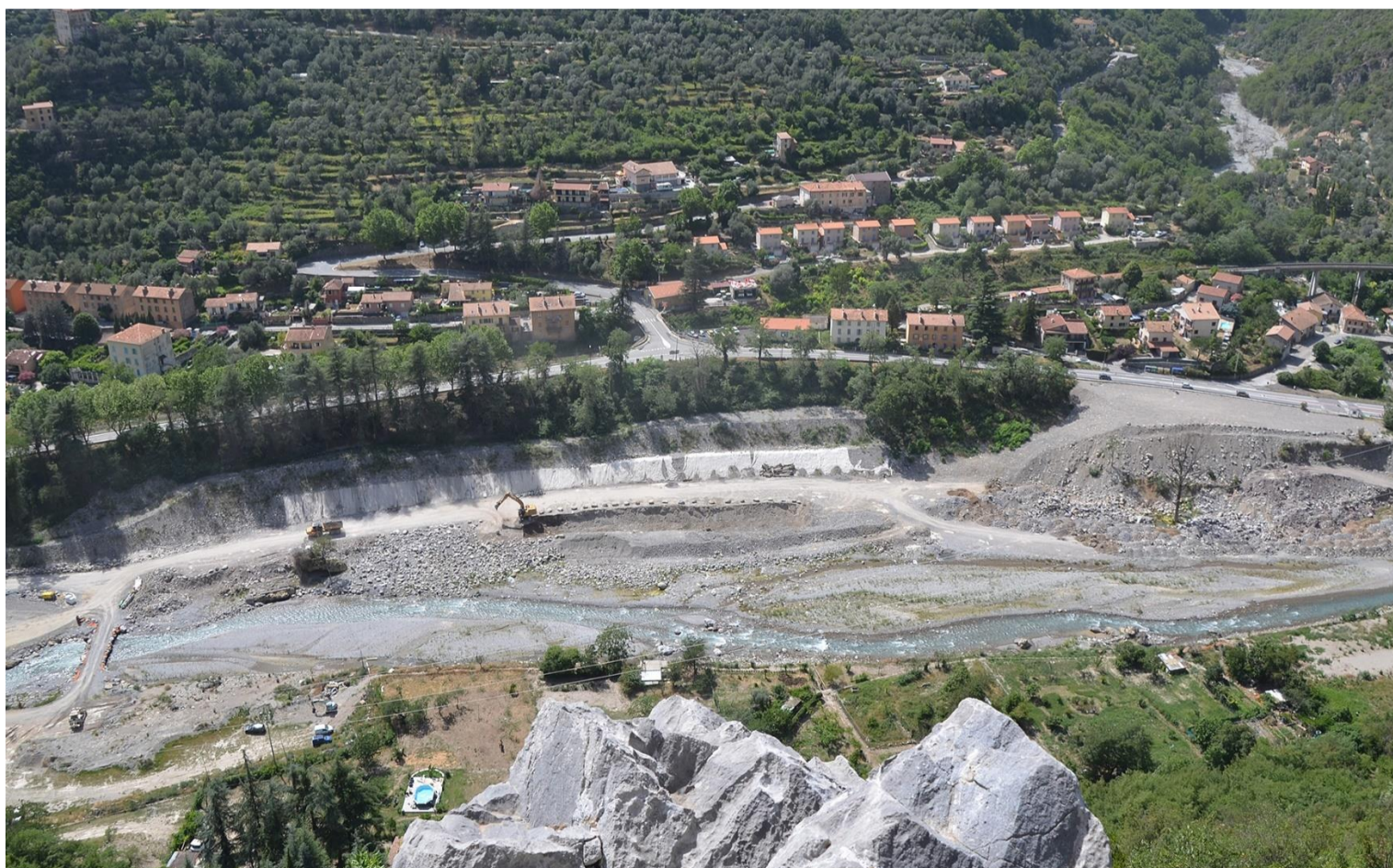
27 juin 2022. Conditionnement de la de la rive droite sous le pont de Nice.
