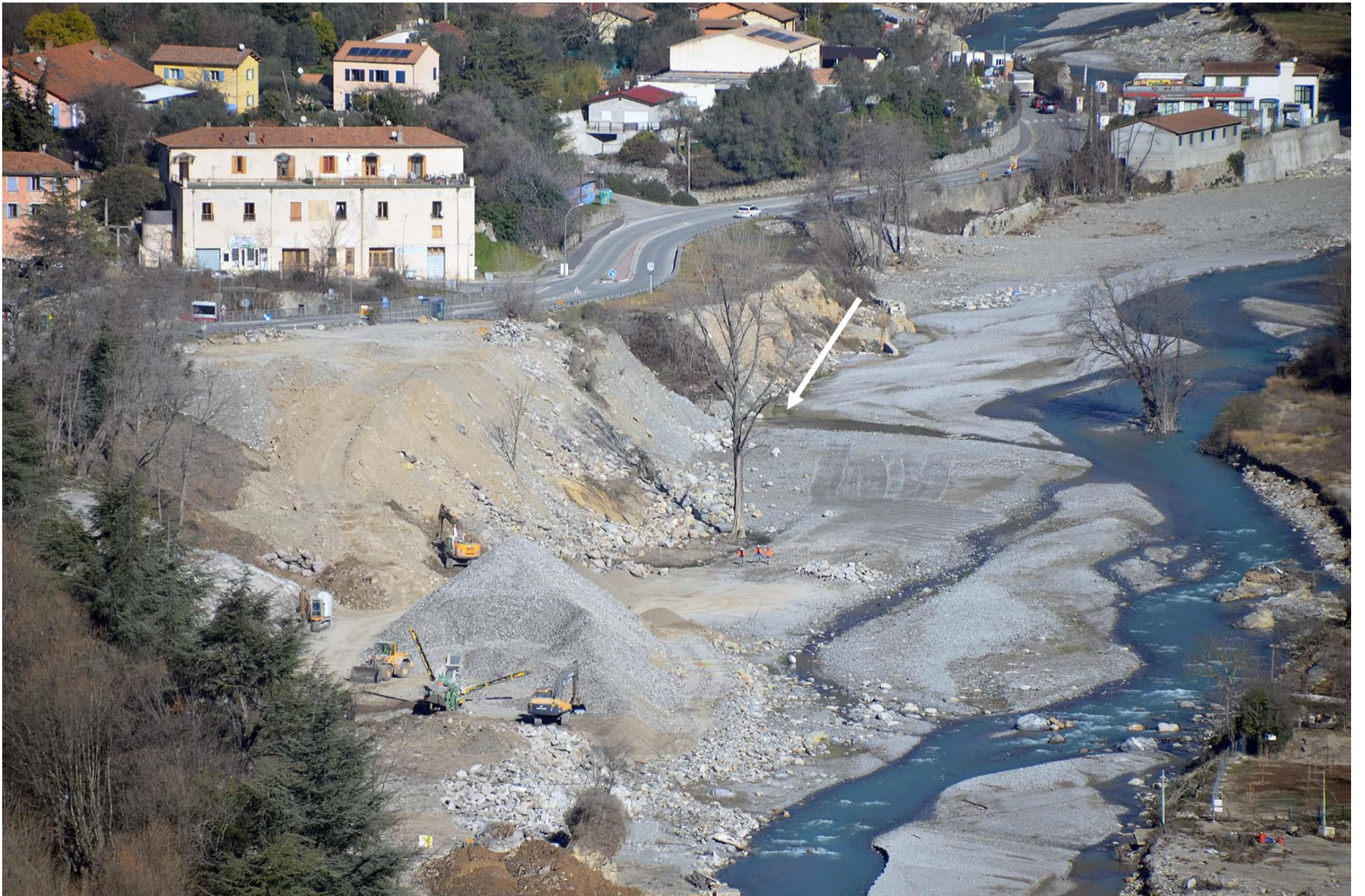
Février 2022. Atelier de concassage des déblais à l'aval du confluent.
