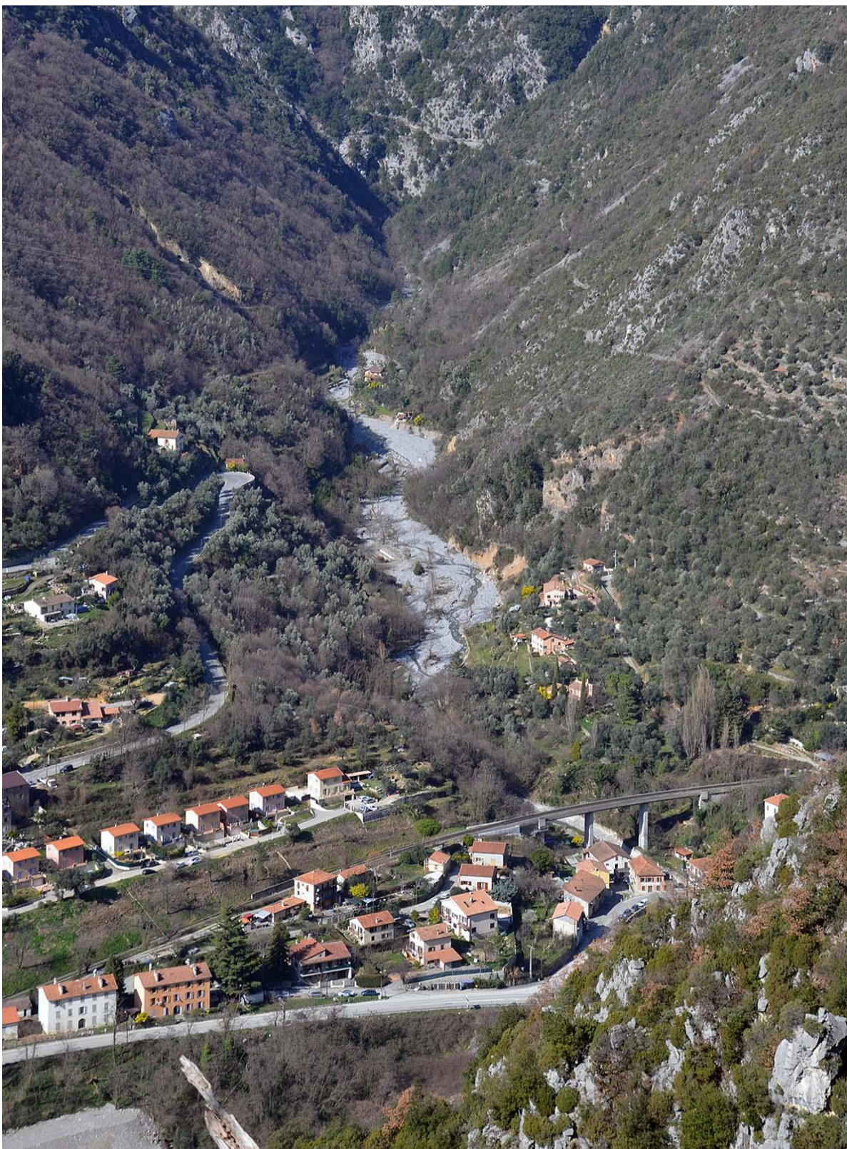
Vue des dépôts consécutifs à la tempête Alex dans le lit de la Basse-Maglia en janvier 2022 (depuis le chemin de l'Orneglia).
