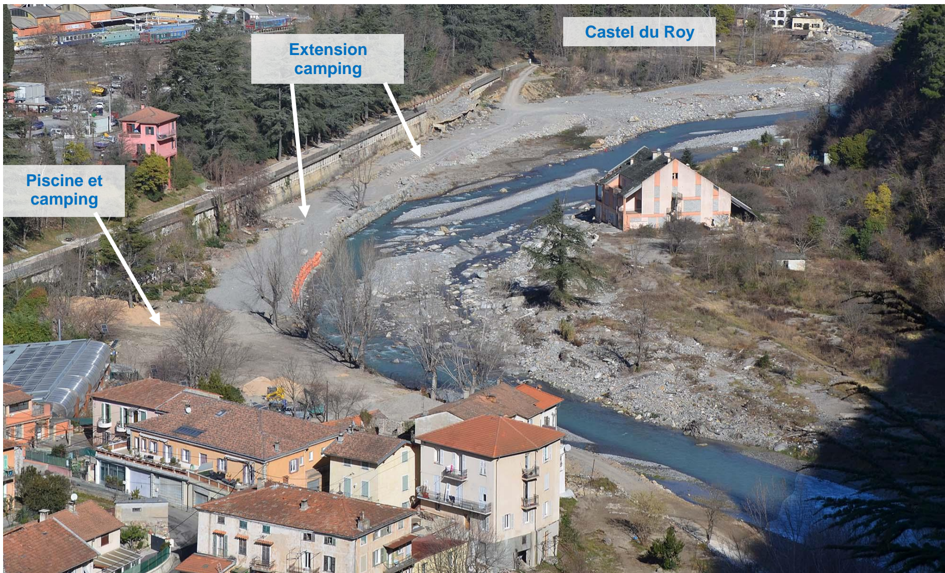
Février 2022. Camping remblayé à l'arrière d'un enrochement.
