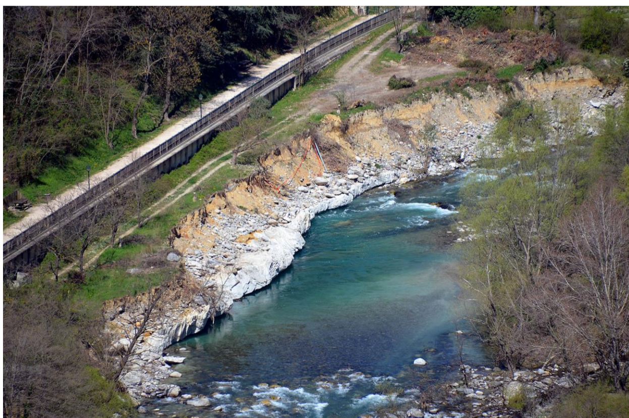
Avril 2015. Arrachement du nord du camping par une crue.
