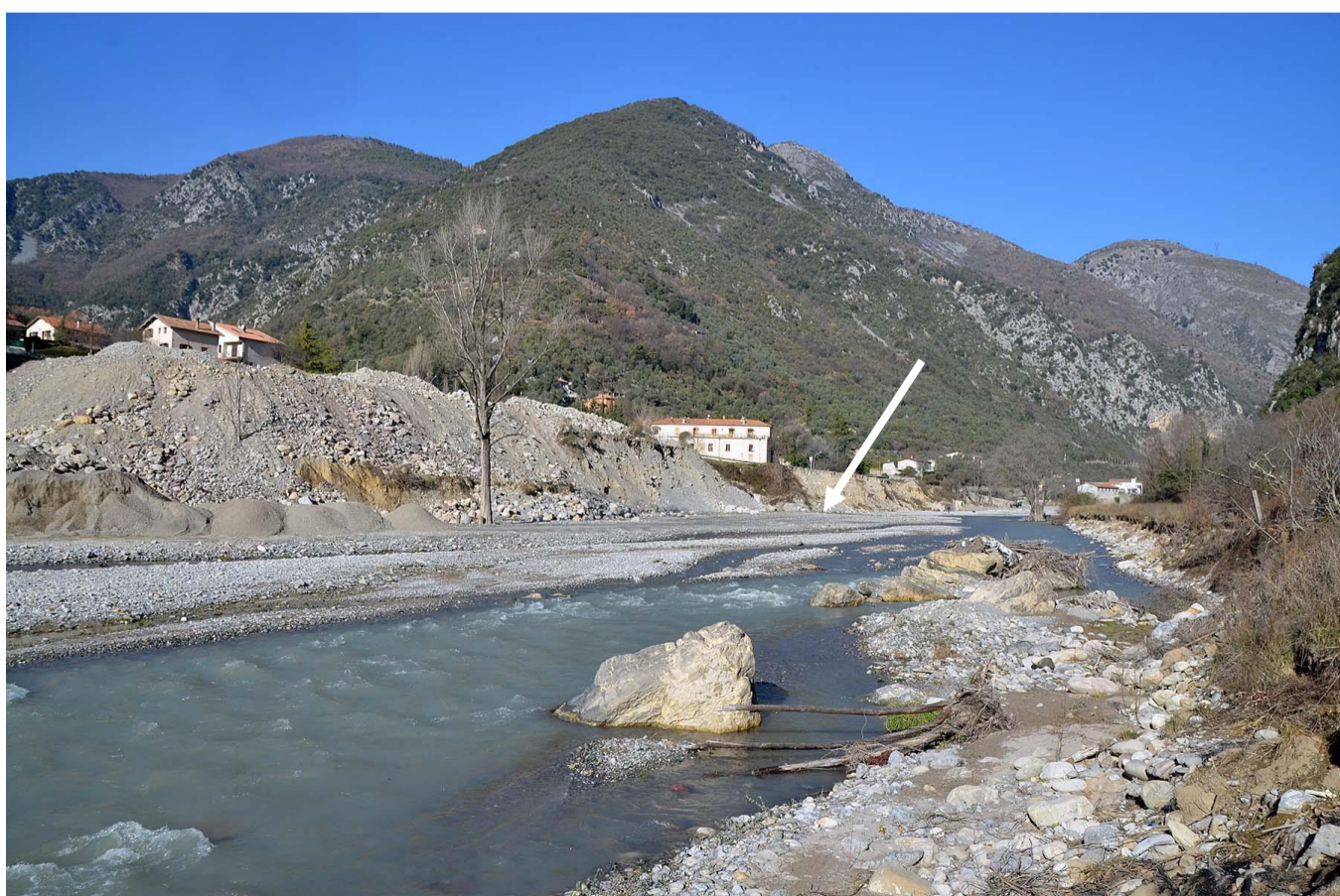
Janvier 2022. Confluent de la Maglia en amont du nouveau talus de déblais, depuis le SE, en rive gauche.
