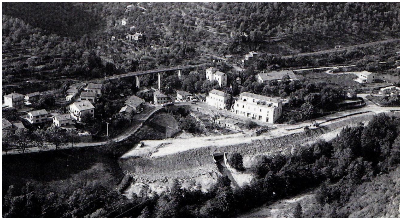
Octobre 1989. Réduction du lit de la Maglia au confluent par la construction d'une route sur talus avec cadre-buse.
