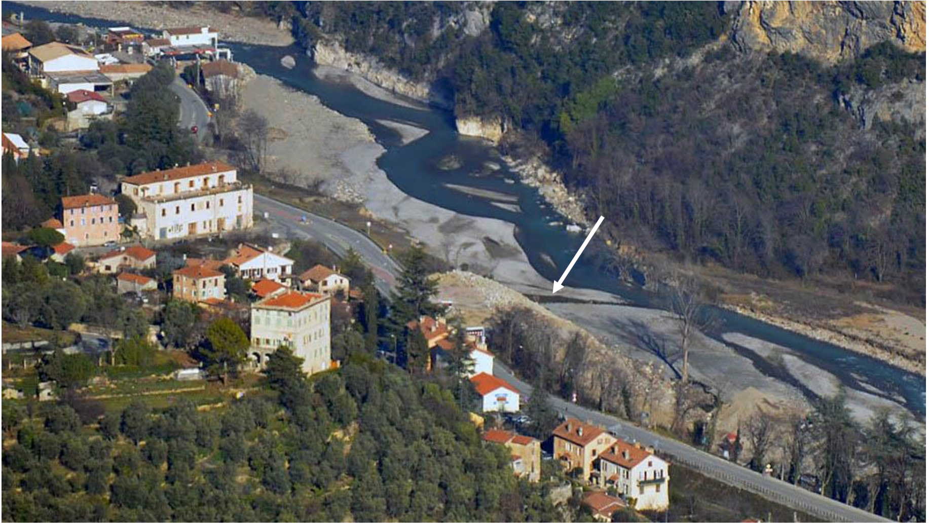
Janvier 2022. Confluent de la Maglia (sous la flèche). A l'aval, le nouveau talus de déblais. Vue depuis le S-O.
