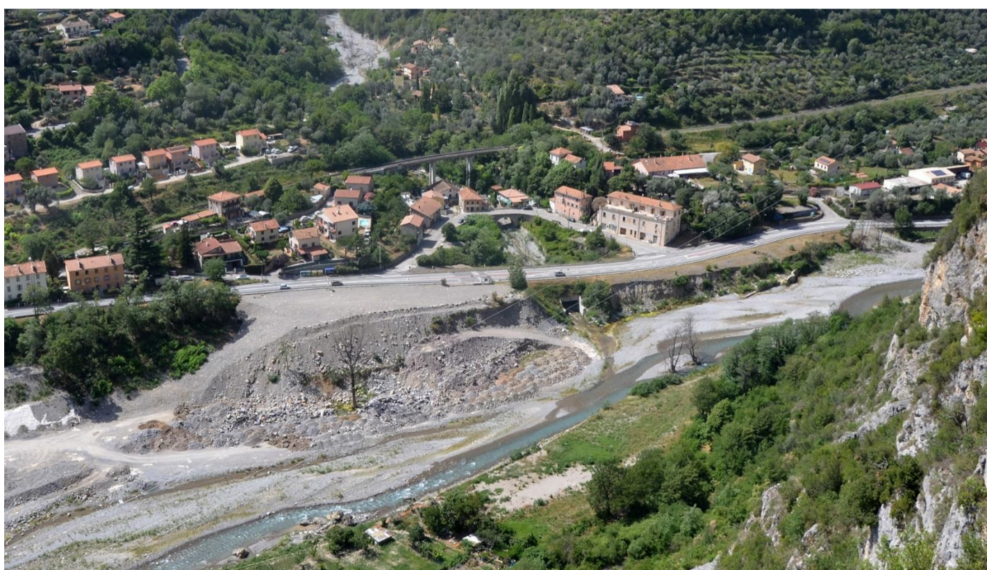
27 juin 2022. Conditionnement de la zone de remblais recréée à l'aval du confluent.
