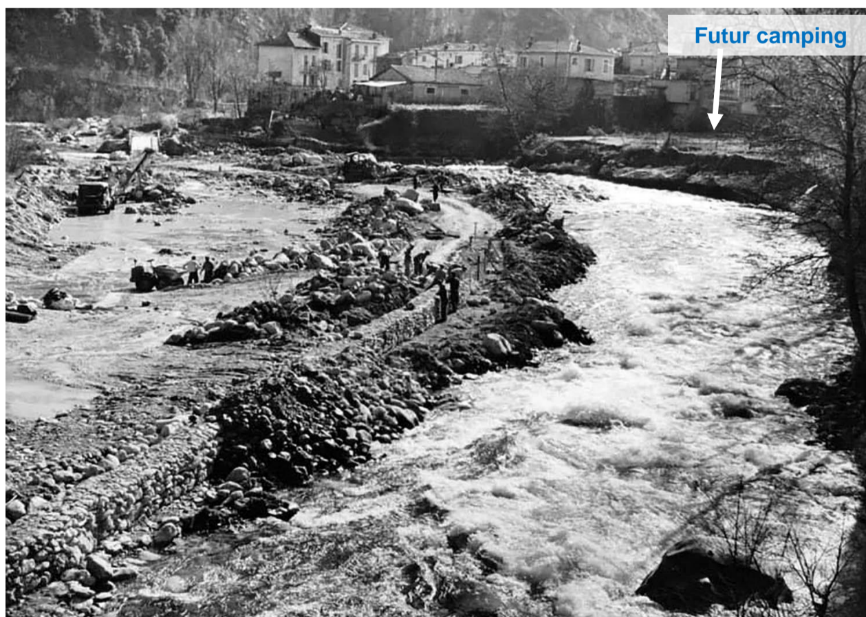
secondaire Sud, avec alignement de gabions sur la berge, vu depuis le NO (promenade Goulden)
