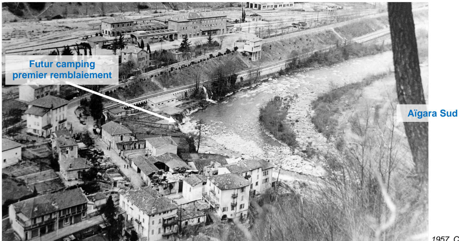
1957. Courbe du camping vue du SE (chemin de la Cruella). Premier remblaiement du camping réalisé. Bras secondaire sud encore actif.
