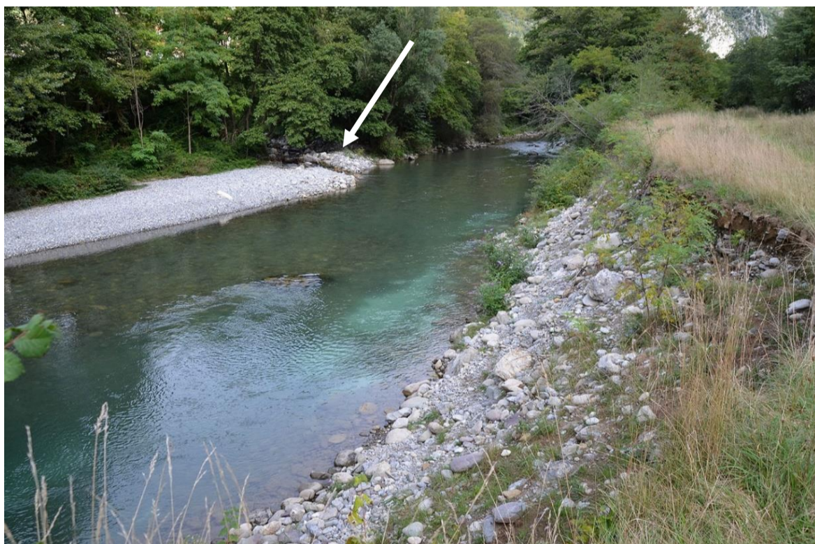
Septembre 2016. Confluent de la Maglia entre les talus de déblais végétalisés, depuis la rive gauche.
