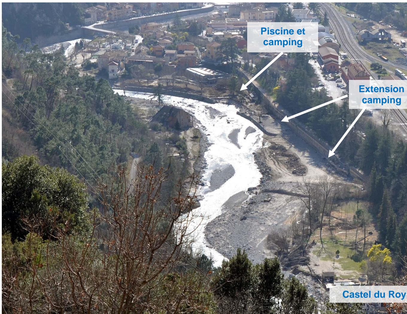
Février 2021. Vue depuis le nord (chemin de l'Orneglia).
