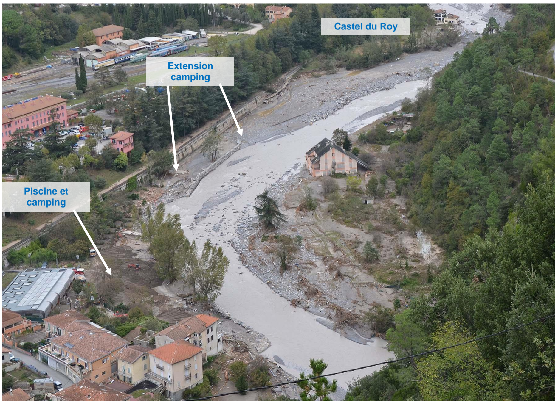
Octobre 2020. Berges du camping arrachées. Lir de la Roya rempli de dépôts. Berge de l'Aigara Sud reconquise par le lit majeur.
