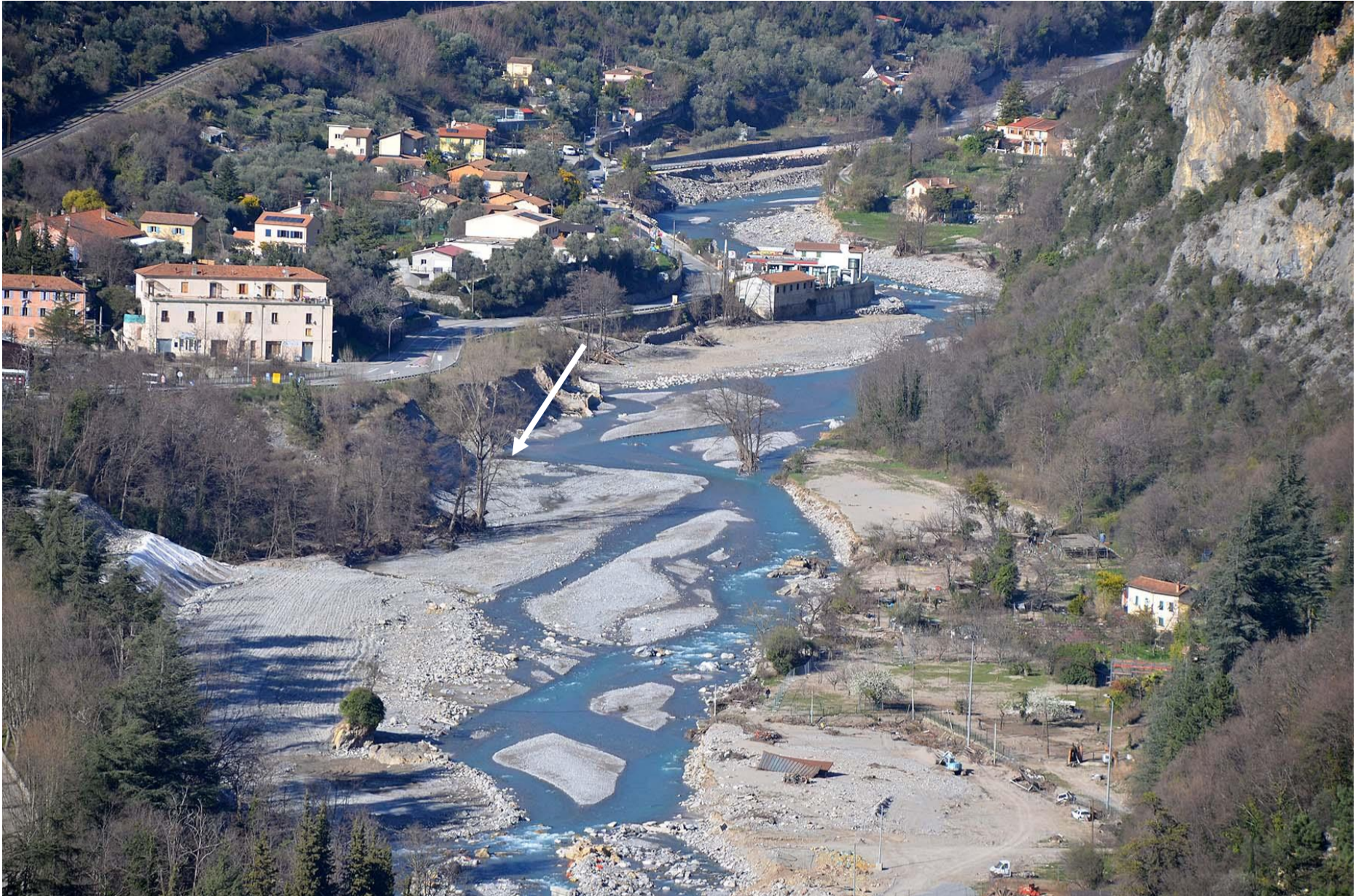
(Date) 2021. Vue du confluent depuis le Sud (La Cruella) avant la création de l'atelier de concassage des déblais.
