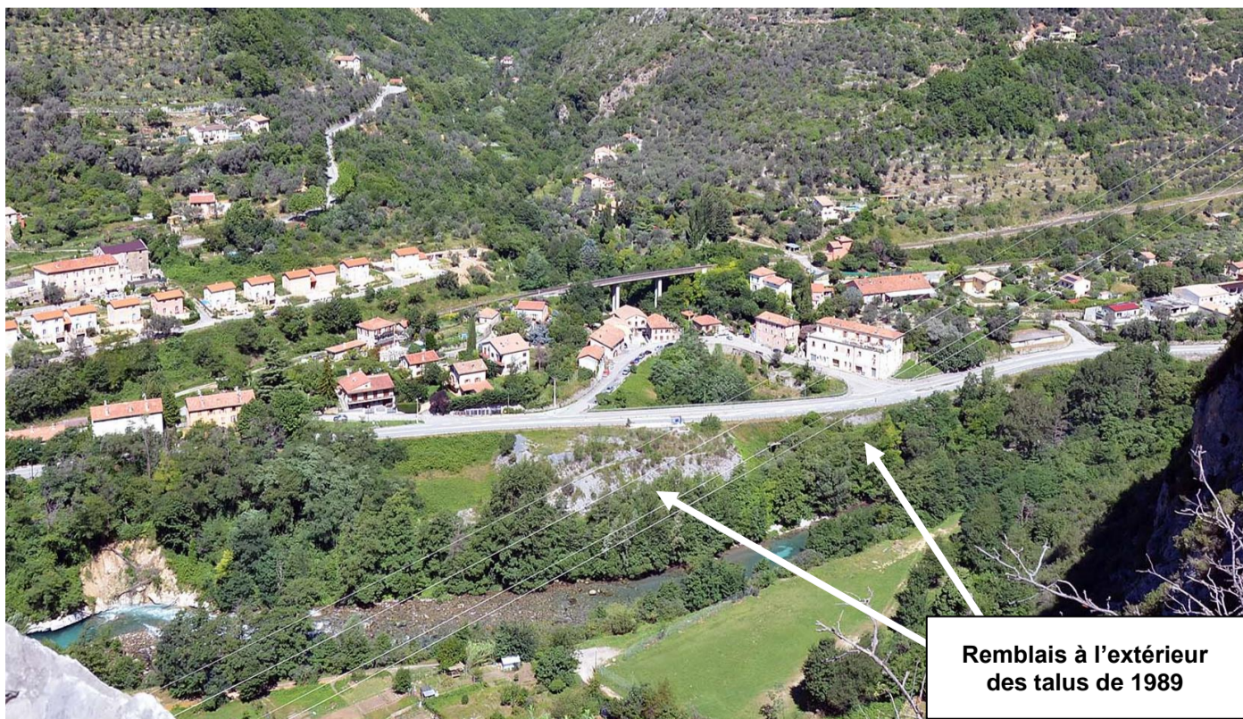
Vue en 2017. Des remblais de creusement des tunnels de Saorge ont été rajoutés avant la fin du XXe siècle, à l'extérieur du talus de la route, en rive droite de la Roya. Ces remblais avaient été colonisés par la végétation.
