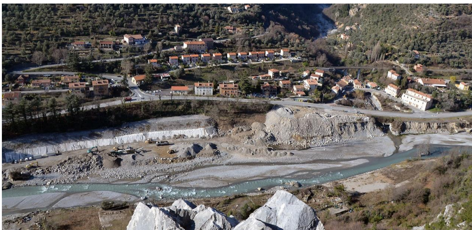
20 janvier 2022. Le talus sous le pont de Nice a été renforcé suite au déplacement du lit mineur de la Roya. Un petit atelier de concassage a été installé sur la plage créée par la crue sous le pont de Nice en supprimant des arbres sur la berge.
