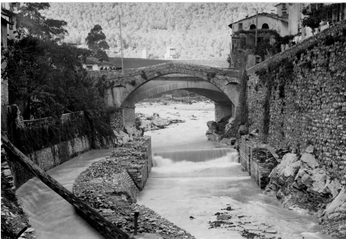
Prise d'eau - Crue de la Roya - Etat des travaux au 23 oct. 25
