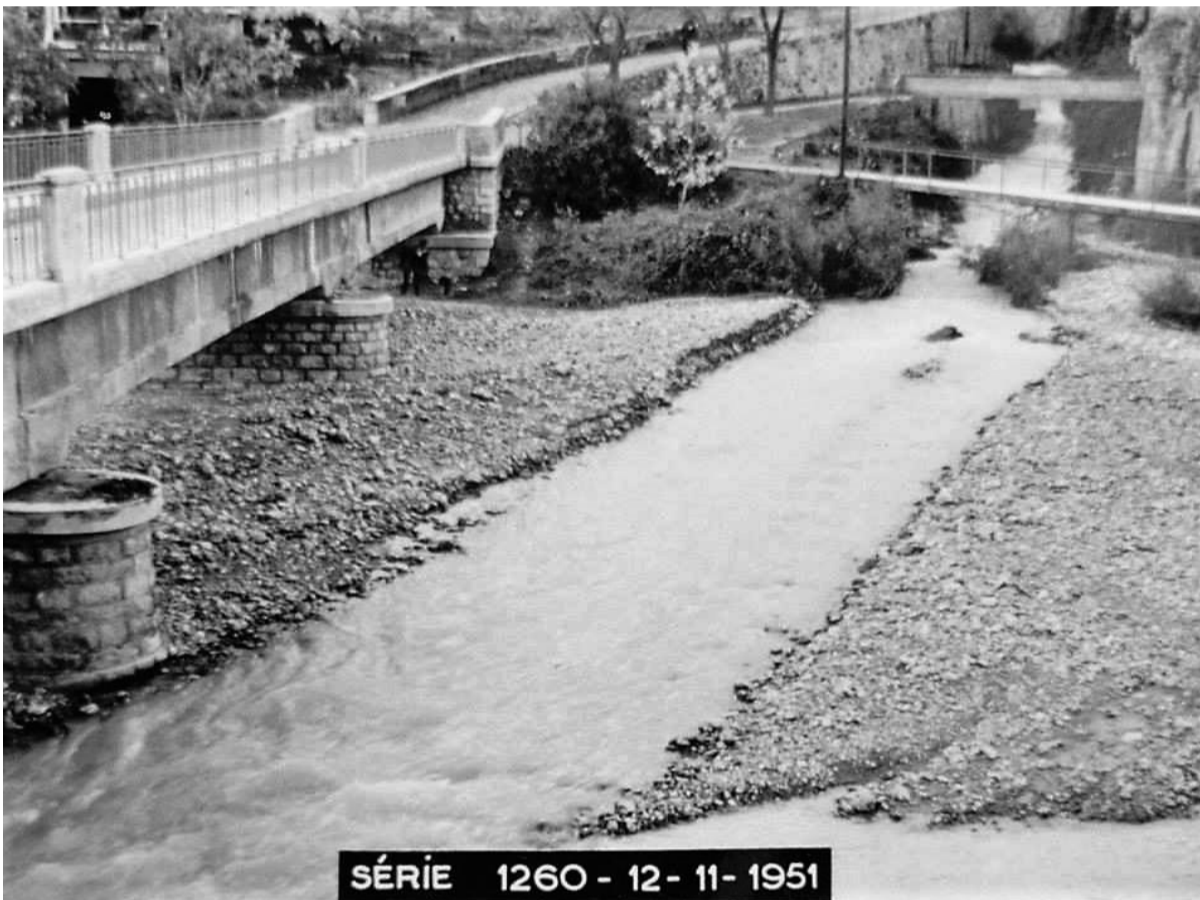
Cette vue du 12 novembre 1951, montre les dépôts de la Lavina déposés contre le pont Charabot dans la Roya, pendant la crue du 10 novembre précédent. A cette époque, deux passerelles légères permettaient de franchir la Lavina, vers le Graïou et vers l'Isola. (Collection JL Taylor)
