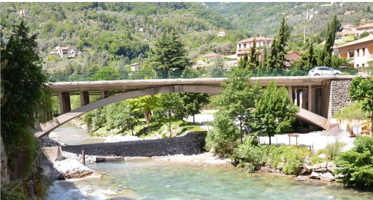
Vue prise en juillet 2014, pendant réfection de la vanne EDF, et le détournement de la Roya par les tunnels écrêteurs de crue. La voie sur berge créée entre l'Isola et le camping occupe près de la moitié du lit majeur de la Roya.
