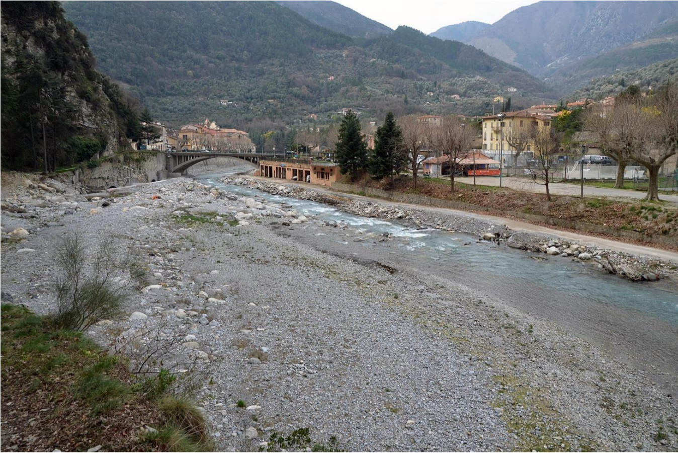
Vues de la voie reconstruite dans le lit majeur de la Roya.
