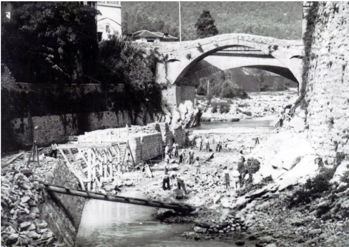
installation de la prise d'eau
