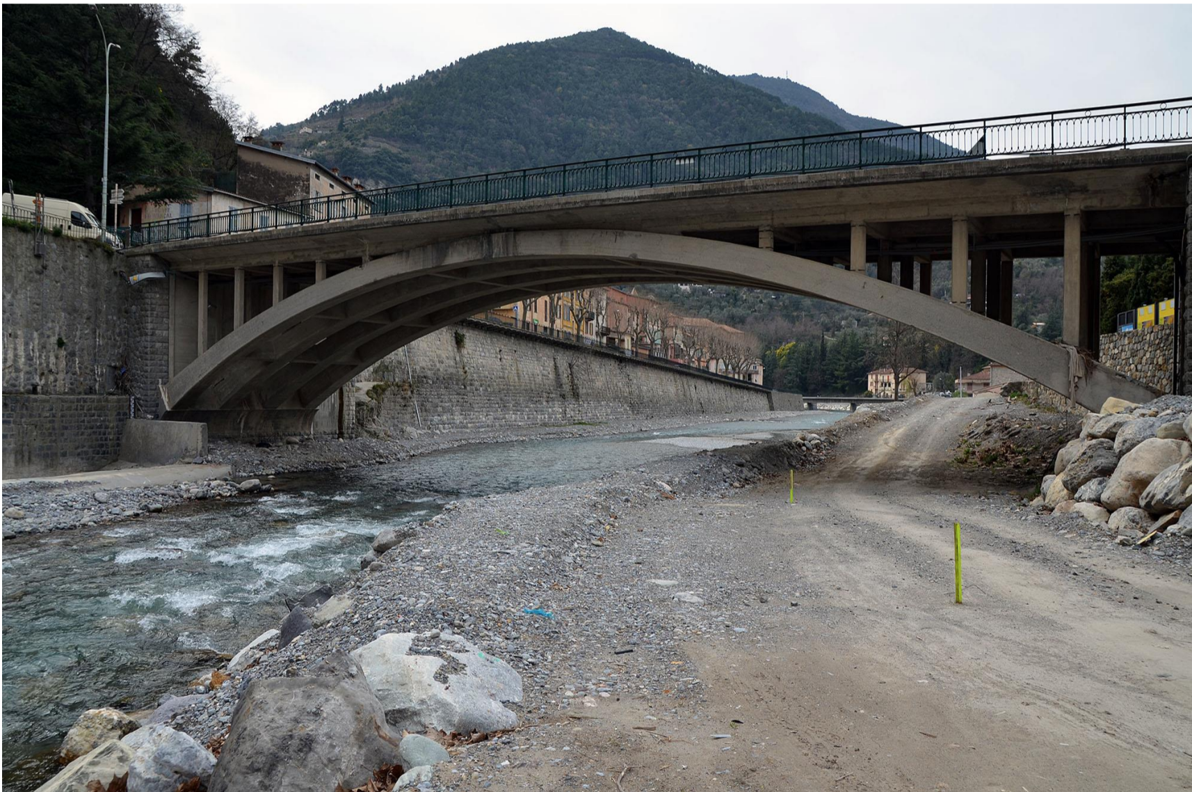
berge a été reconstruite sous le pont Supérieur.
