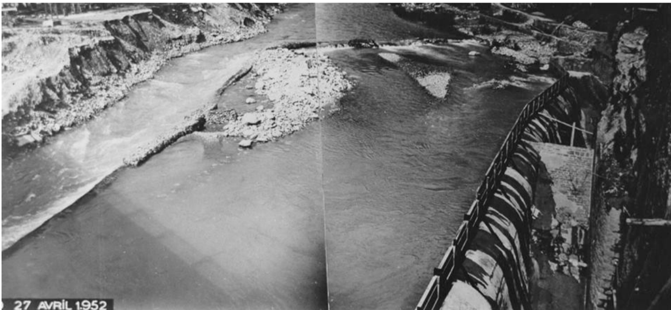
27 AVRIL 1952 Avril 1952. Fonctionnement avec réhausseurs de batardeaux. Les réhausseurs, qui n'étaient enlevés que pendant les périodes de crues majeures (voir cahier technique n°5) permettaient de ne pas écreter les crues ordinaires qui participaient à l'incision du lit de la Roya en chassant les sédiments.
