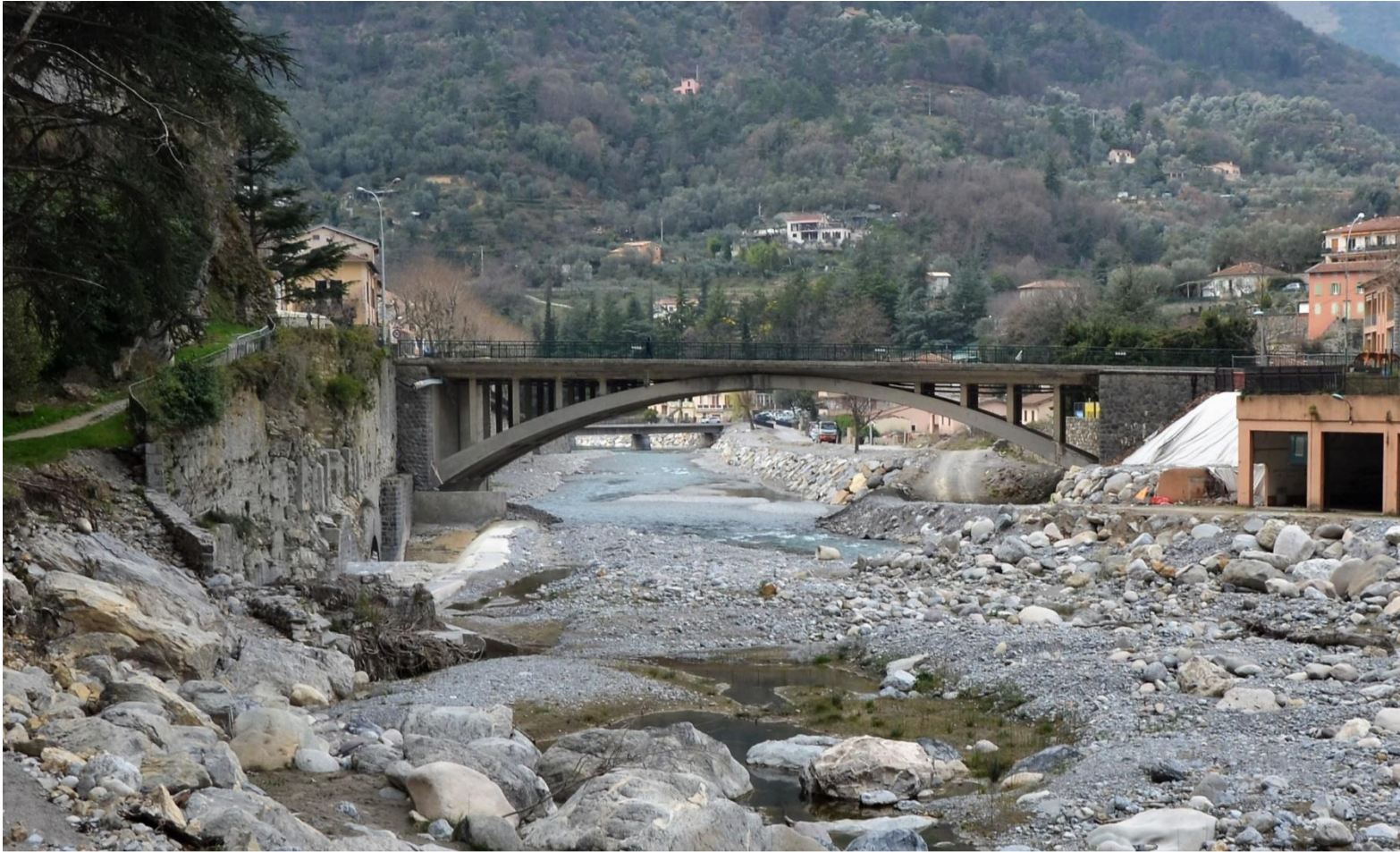
berge a été reconstruite sous le pont Supérieur.
