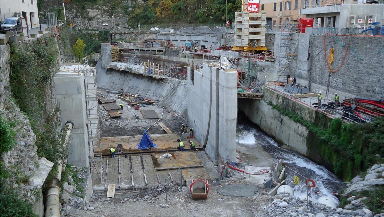
Chantier de remplacement de la vanne en 2013
