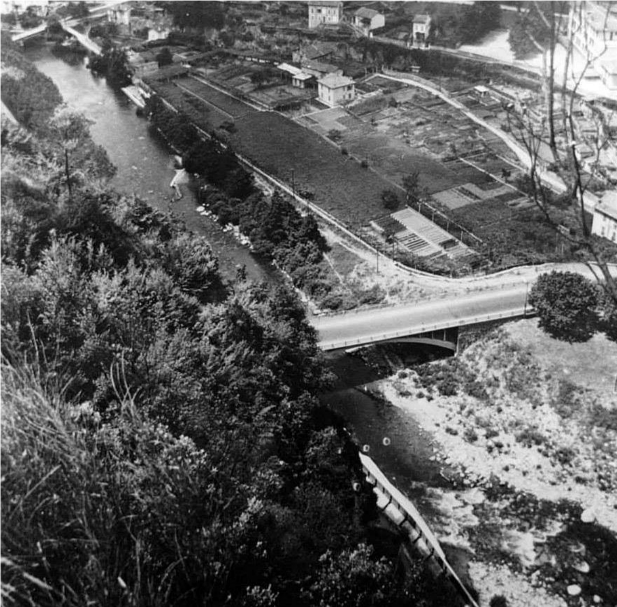
Juillet 1957. La culée nord est cernée au nord par le talus de l'esplanade créée, et au sud par l'accès créé vers la voie sur berge de l'Isola.
