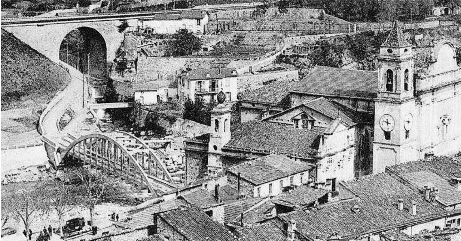
1930. On observe, sur cette vue, l'emprise de la culée ouest du pont dans le confluent.
