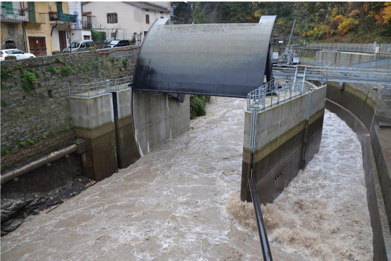
Vanne ouverte pendant la crue de 2016.
