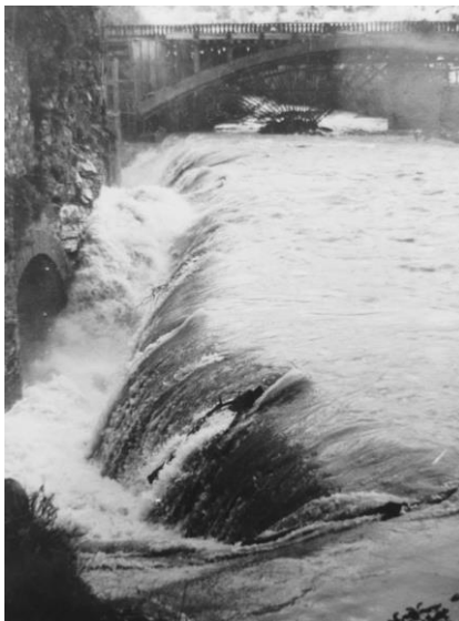
Vue des avaloirs des tunnels écrêteurs de crues, pendant la crue de 1951.
