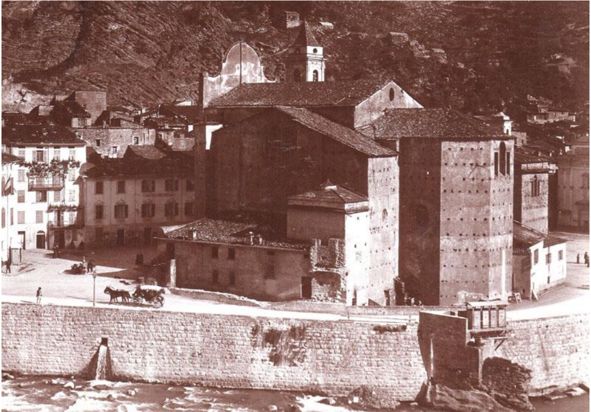
Vue d'ensemble en 1895, de l'îlot de l'église et de la route récemment achevée. A droite, sur une arête rocheuse, les vestiges de la digue historique qui éloignait les eaux de la Roya de l'église, disparus dans l'élargissement du virage en 1985. (Collection JL Taylor)
