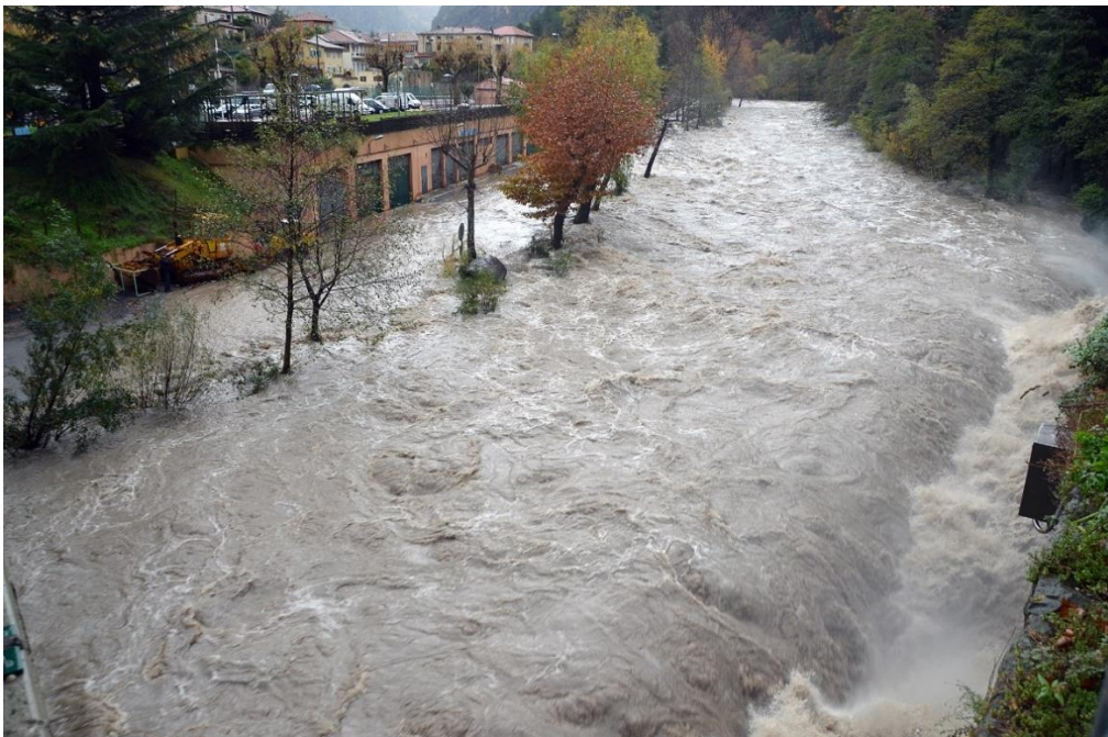
Vue des services techniques et de la voie submergée face aux avaloirs des tunnels écreteurs de crues à midi.
