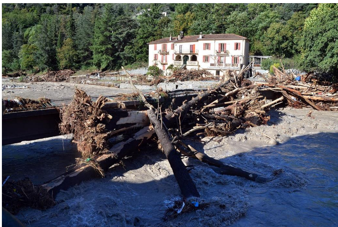
Vue de l'embâcle sur le pont Charabot, pendant la décrue, le 3 octobre 2020 à 10h30.
